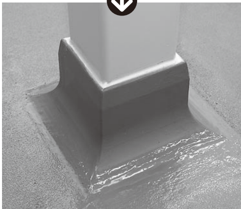
アルミ製R幅木もエポキシ樹脂で塗る。柱と幅木のすき間にほこりなど入らないようにするため
