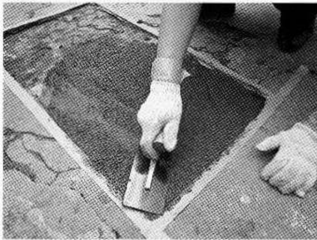
基準の厳しい食品工場の床などに対応 (ウレガードプロの施工風景)
